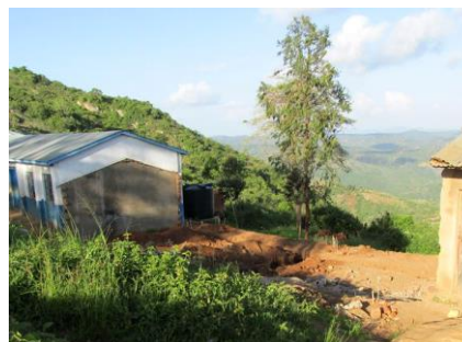
↑会報64号(2013年9月)で崩壊していた2つの教室を更地に—2013年12月。
