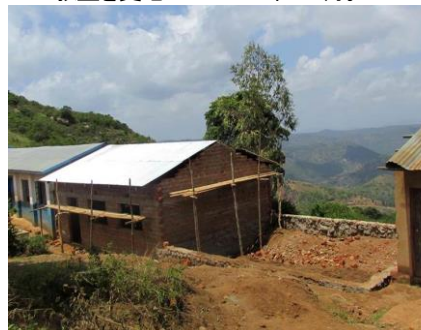
↑上の小学校では、土壌保全をしっかりとしてから、教室を建設—2014年4月。
