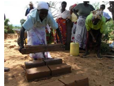
学校-教室建設
