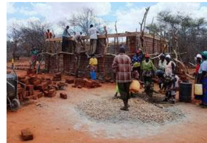
学校：教室建設
