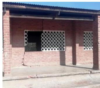
大きな亀裂が入り、壁の上部を支える窓も外れ倒壊が心配される教室/この学校では一般保護者向けの2回目の研修を終了。
