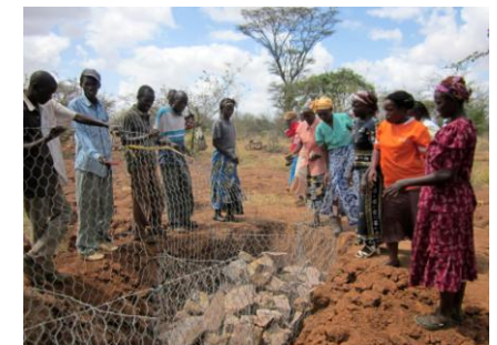
↑ 金網の中に石を入れる大きな塊「蛇かご」の設置
