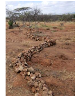
↑ 等高線に沿って、石を積み上げる「石堤」の方法
